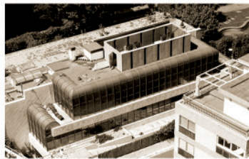
Estado previo a la rehabilitación.
