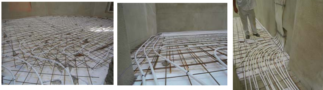
Ejecución de solera activada con tubería de polietileno reticulado
